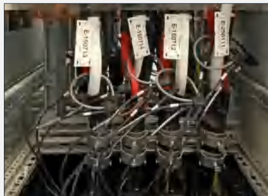
电流链路模块现场安装
