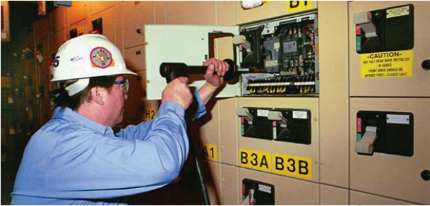
使用HCP2000对模制外壳断路器进行测试
